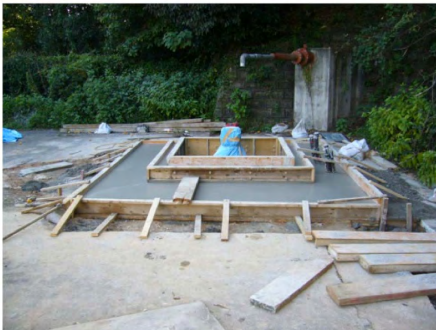
図3-14 No2震源の基礎が完成した様子。
