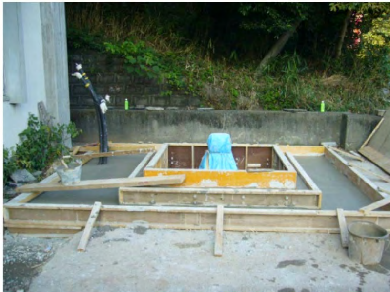
図3-1 3 No 1震源の基礎が完成した様子。
