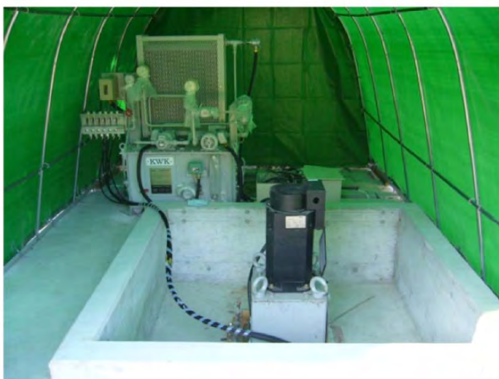
図3-15. 潤滑油の冷却循環装置を設置した後、簡易車庫で覆ったところ。
