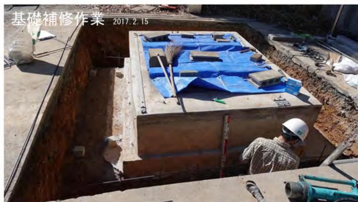
図1 震源装置の基礎の補修工事。
